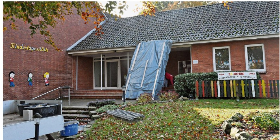
In der Portenstraße gehen zurzeit die Handwerker ein und aus: Die Sanierung der Kita Kuhstedt kommt gut voran. Noch in diesem Jahr sollen laut der Gemeindeverwaltung die Arbeiten an dem Gebäude aus dem Jahr 1962 abgeschlossen werden.
