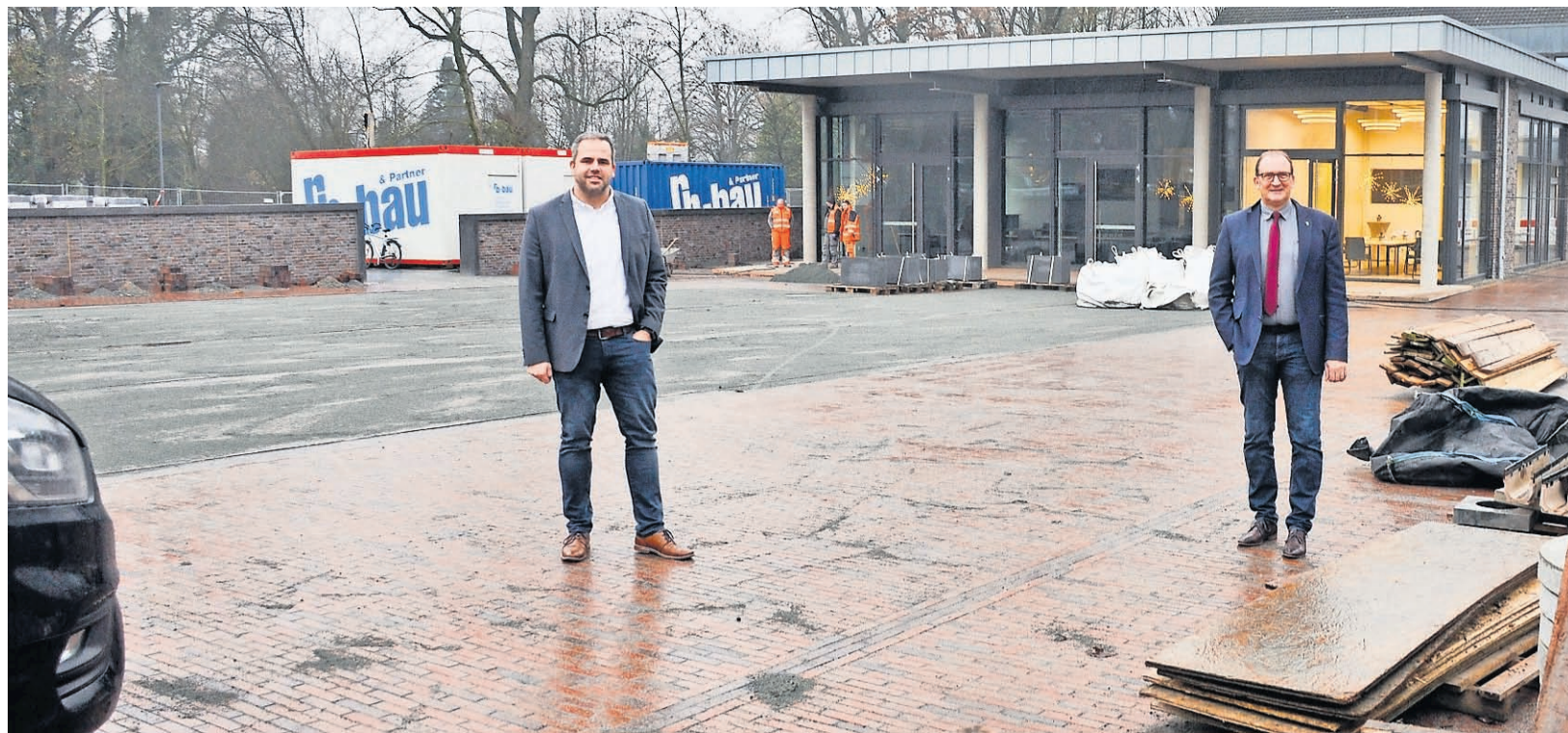
Das Wetter spielte zwar nicht mit beim Fototermin, doch Grund zum Strahlen gibt es in Gnarrenburg um so mehr: Geschäftsbereichsleiter Marcel van der Pütten (links) und Bürgermeister Axel Renken freuen sich, dass es kurz vor Fertigstellung des Millionenprojekts Dorfplatz gelungen ist, weitere Fördermittel bewilligt zu bekommen.
