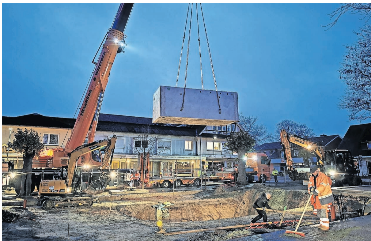
Alles Gute kommt von oben – in diesem Fall ein Bauwerk zur Unterbringung technischer Anlagen zur Wasseraufbereitung für ein Wasserspiel auf dem neuen Dorfplatz in Gnarrenburg.
